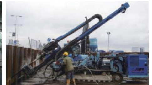
恶劣环境高负在工况下使用的施工钻机
